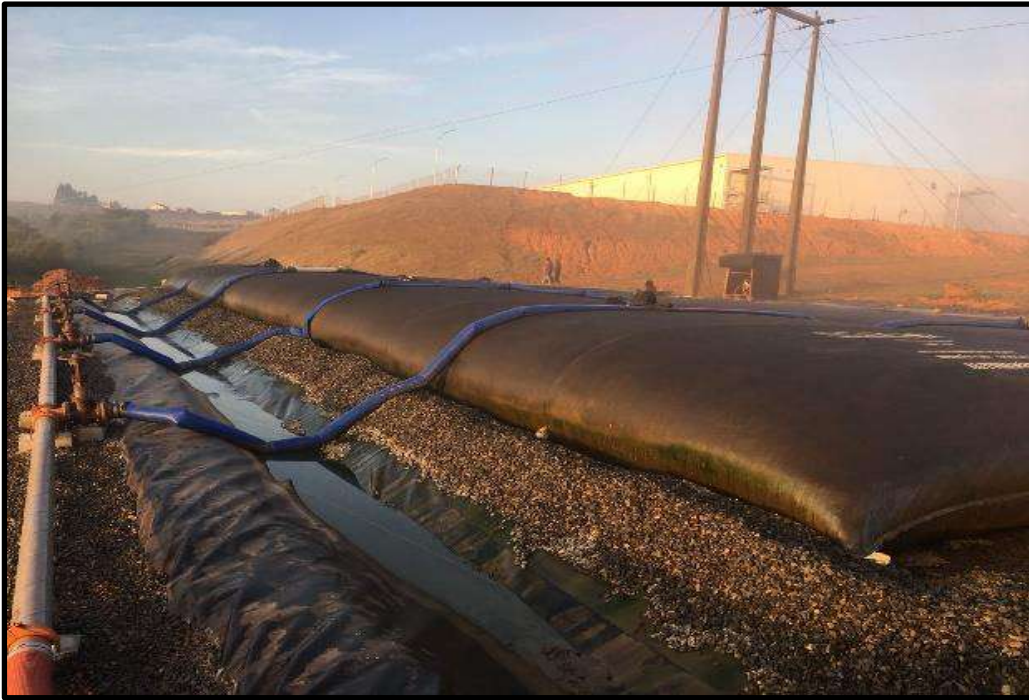
Figura 15. Geobags em operação.
